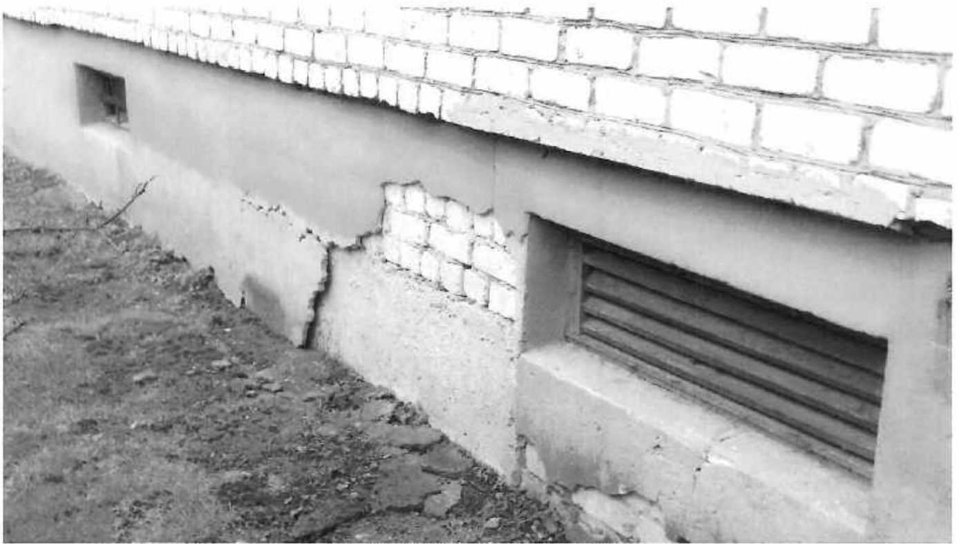
4pav. Suskilinėjęs ir nutrupėjęs cokolis.
